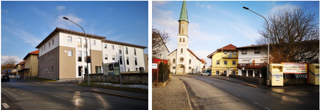
Abb. 10 und 11: Gebäude entlang der Hutthurer Straße
