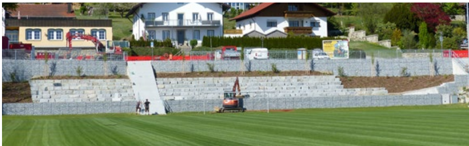
Granit spielt in der Ortsgestaltung immer noch eine bedeutende Rolle. Hier wurde die neue Stützmauer vom Fußballplatz zur Hauptstraße hoch mit Granitquadern angelegt. Eine stabile, geschichtsträchtige und dennoch moderne Lösung.
