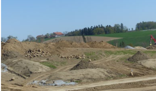
Das Baugebiet „Katzendorfer Feld“ nimmt Form an.
