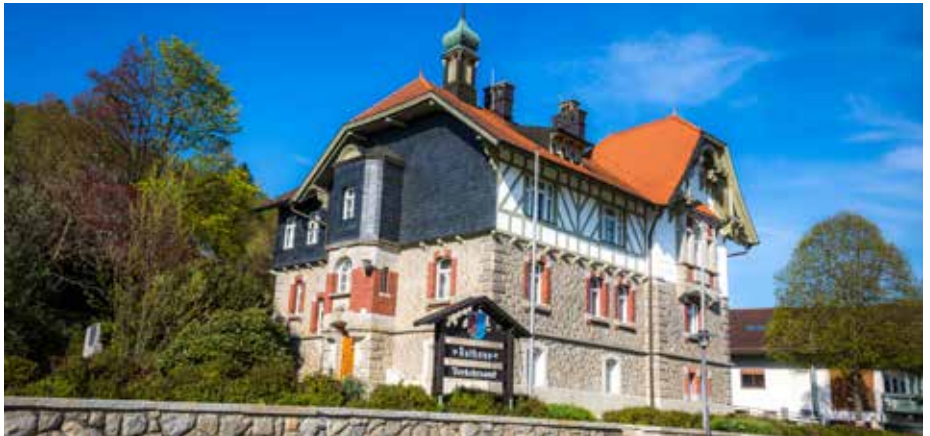
1994 erfolgte eine umfangreiche Sanierung unter Berücksichtigung des Denkmalschutzes. Foto: Karl-Heinz Schoppa
